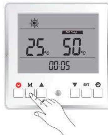
Huoneen lämpötila ohjaus
