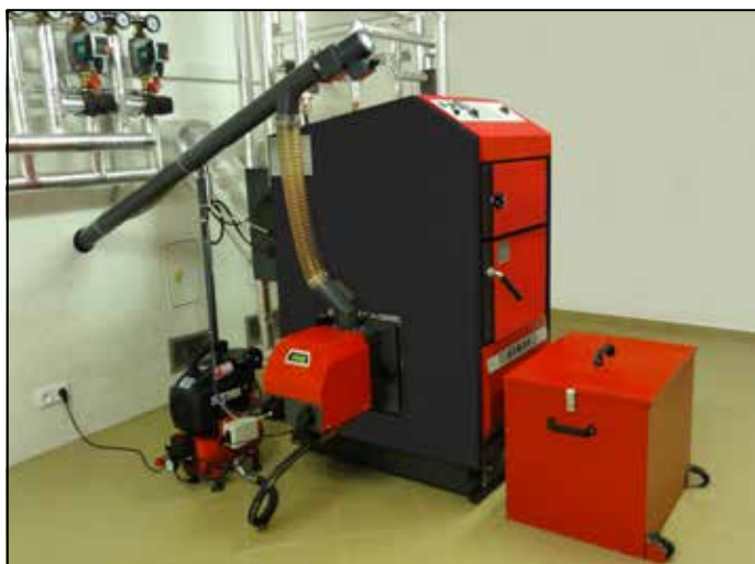
D50P kattila varustettu polttimella, paineilmapuhdistuksella ja tuhkaruuvilla 68 litran tuhkalaatikolla
