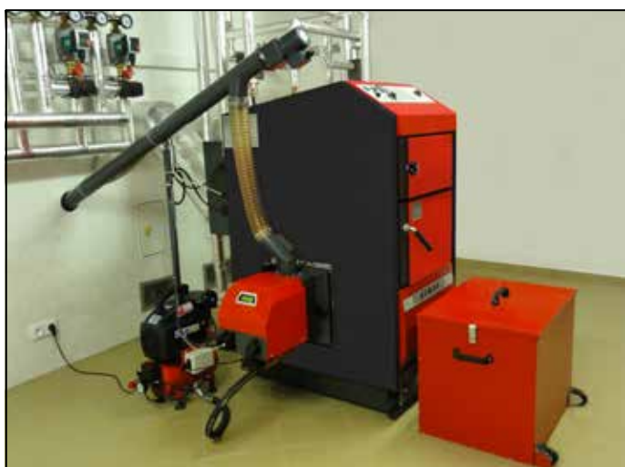
D50P panna med brännare, tryckluftstotning och askskruv med 68 liters asklåda
